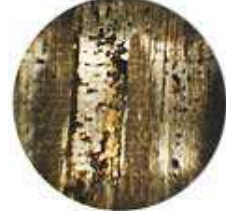
putcorrosie en slijtage
